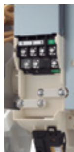
Nagyobb munkaterület a vezetékek bekötéséhez.
